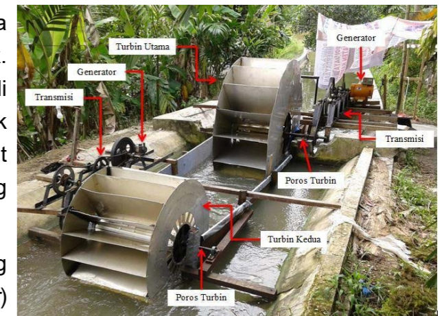
Gambar 29. Pembangkit Listrik Tenaga Air Sumber: https://docplayer.info/61310837-Kaji-eksperimental-turbin-air
